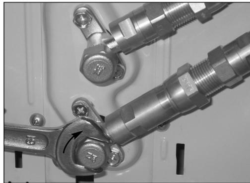
7. Al concluir los pasos 1 – 6, comprobar con aerosol de detección de fugas o agua jabonosa la estanqueidad de todos los puntos de unión. Si se forman burbujas significa que existe una fuga y las atornilladuras han de volver a apretarse sirviéndose de una llave fija.
